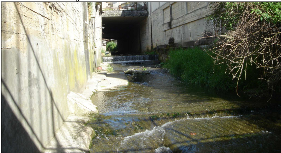
Fig. 10 – ponte di attraversamento a valle di via Piave, in corrispondenza di via Verdi
