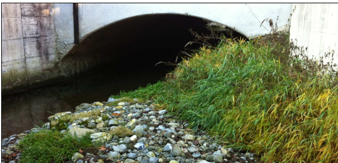
Fig. 4 – imbocco del tombotto in via Piave
