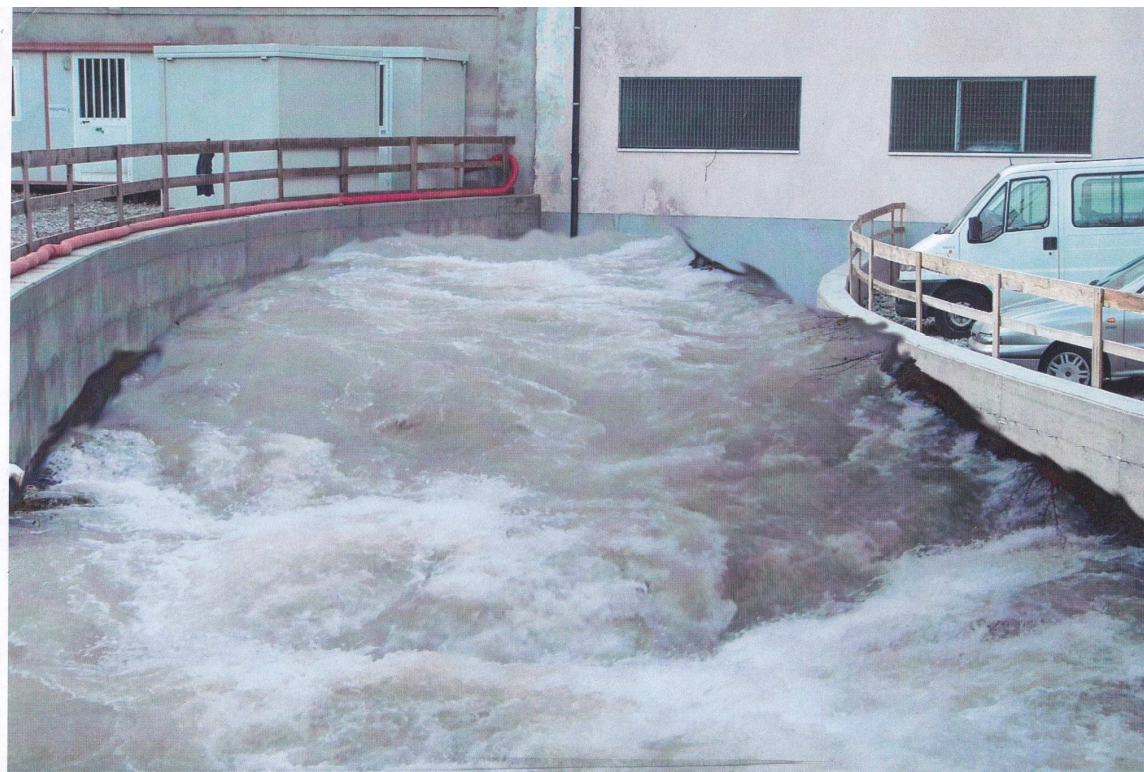
Fig. 12 – fotosimulazione di condizioni di criticità : soglia critica 2 - emergenza (ingresso tombotto di monte di via Piave), documentazione archivi comunali (U.T.)
