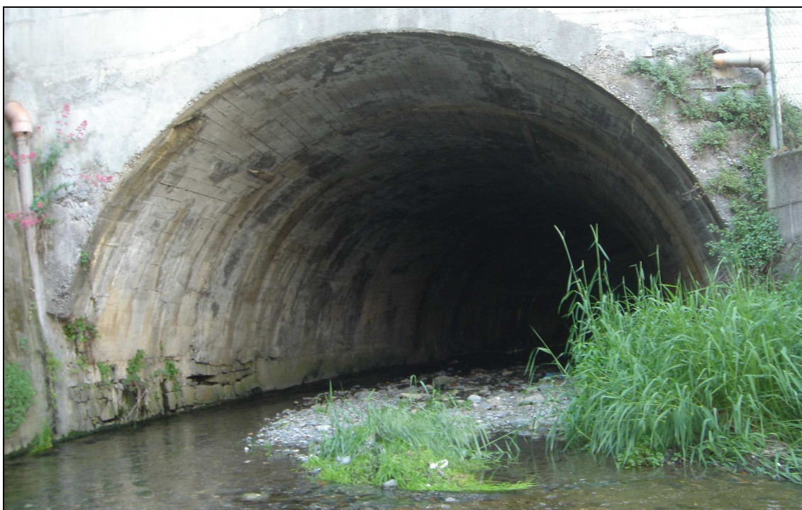
Fig. 8 – sbocco del tombotto in via dei Molini
