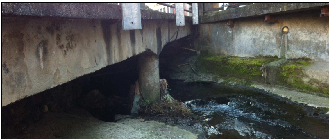
Fig. 5 – sbocco del tombotto in via Piave
