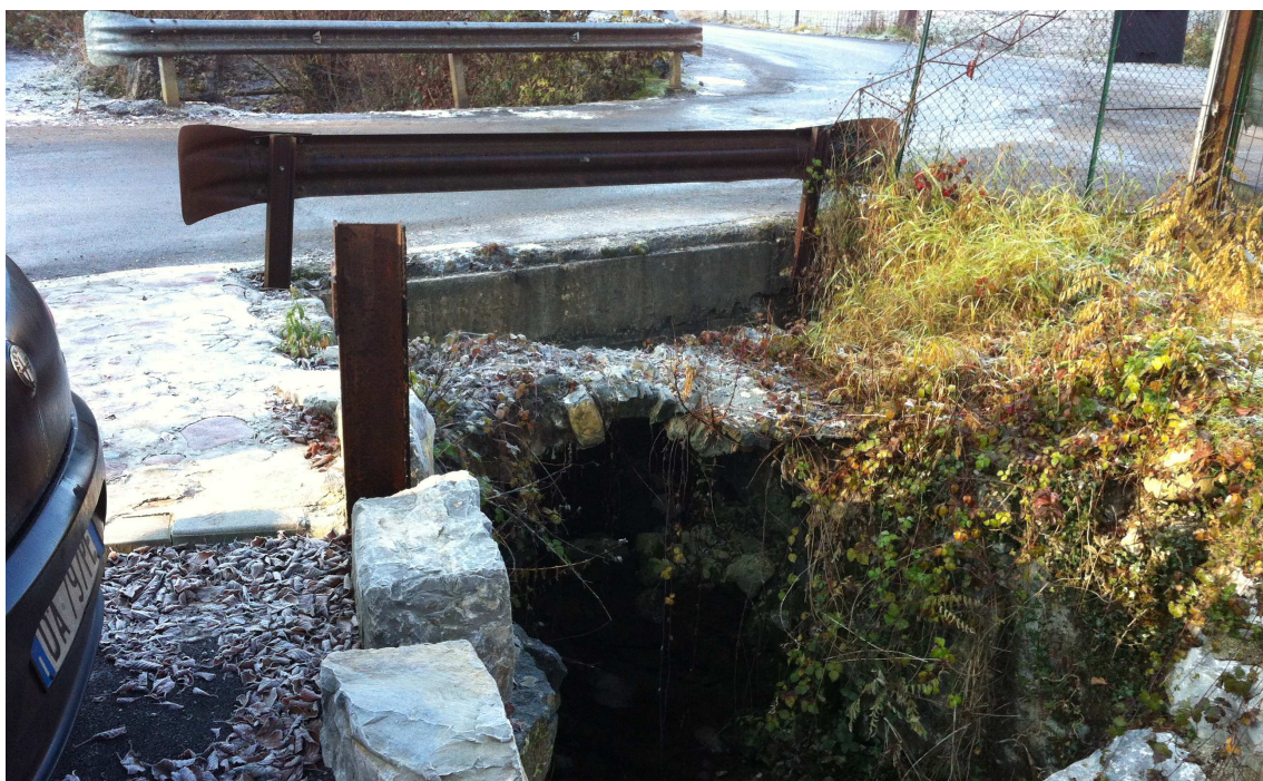
Fig. 19 - sezione di monte critica dell'attraversamento del torrente Rino, tratto di via Stadio a monte dello stadio "Martinelli"
