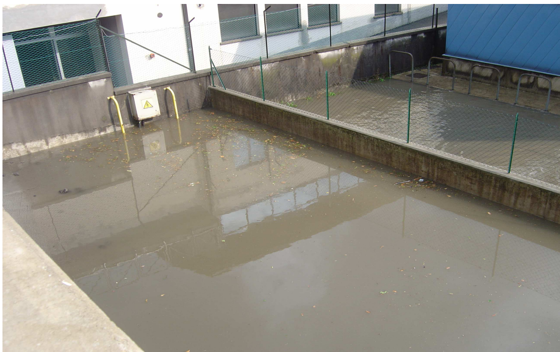
Fig. 34 – allagamenti aree produttive – immagine fornita dall'Ufficio Tecnico del Comune di Leffe
