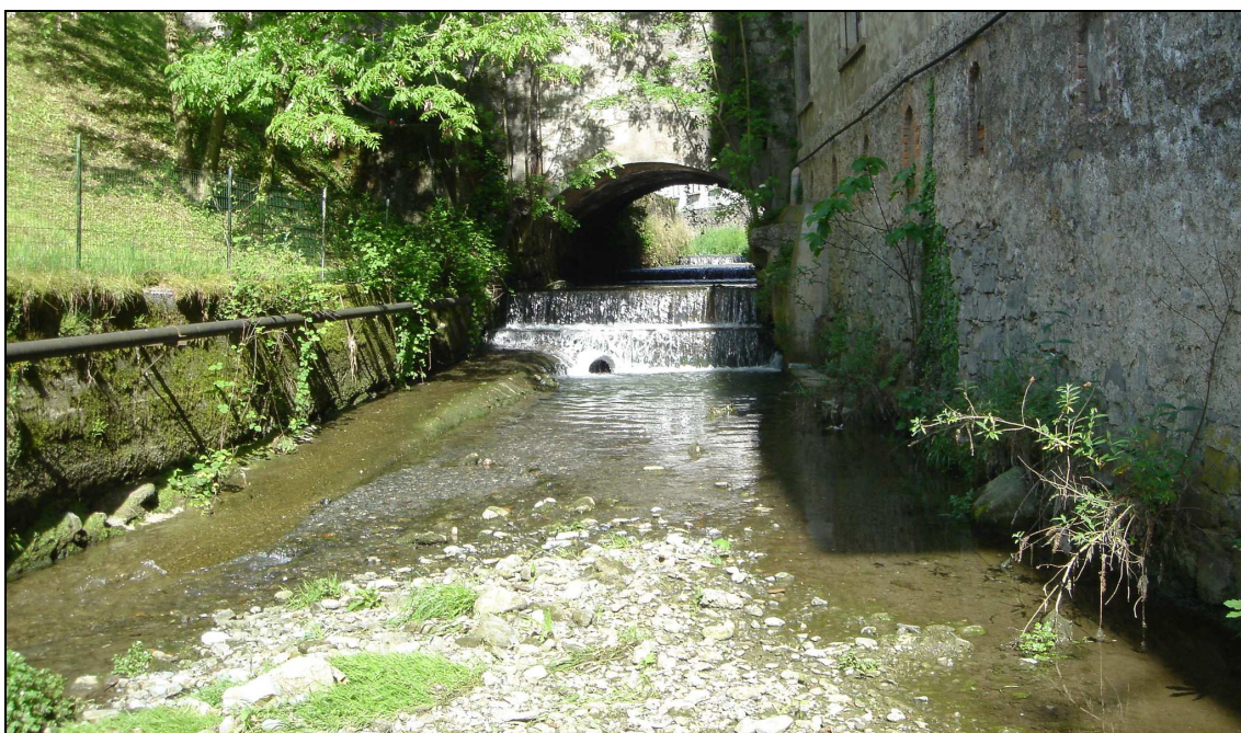
Fig. 6 – ponte di attraversamento in corrispondenza di via Dante
