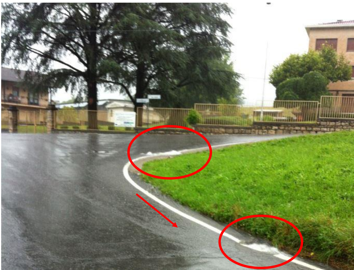
Fig. 37 – ruscellamenti lungo la strada che da via Cav. Radici di Cazzano S.A. conduce verso Leffe (via Fornaci) e fuoriuscita degli apporti fognari dalle caditoie in corrispondenza di eventi meteorici intensi di agosto 2016
