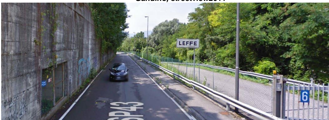
Fig. 22c - Strada di accesso al Comune di Leffe percorrendo la SP n.43 da Gandino verso via D'Albertoni, streetview2011
