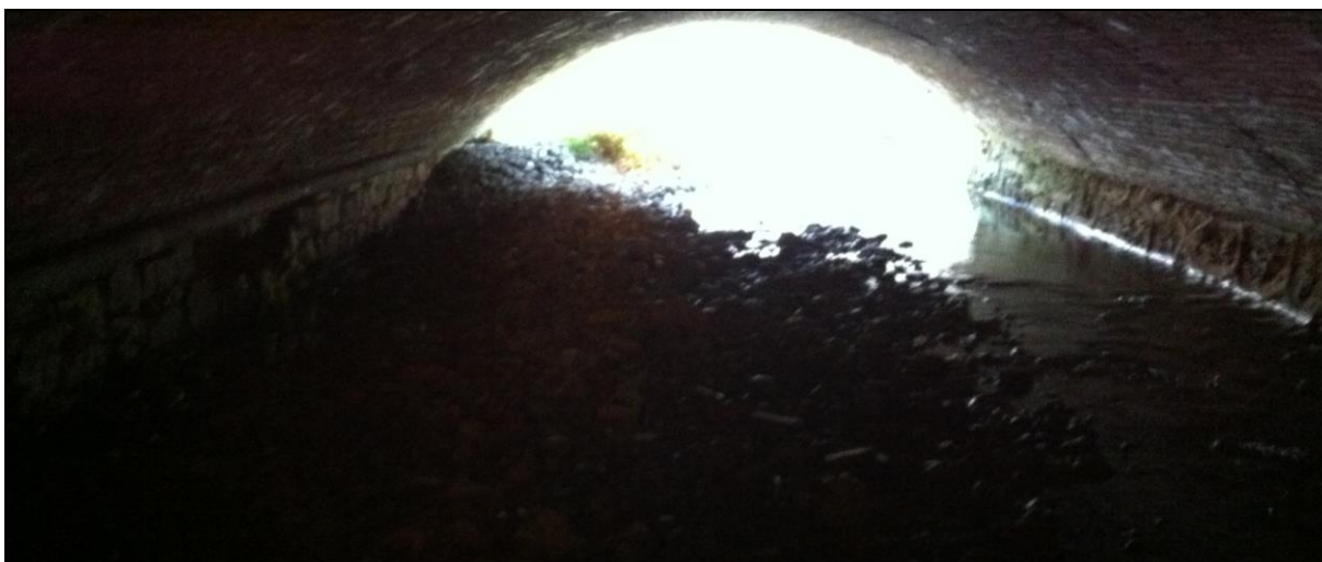
Fig. 29 - tratto di monte del tombotto di via Piave parzialmente ostruita da depositi alluvionali
