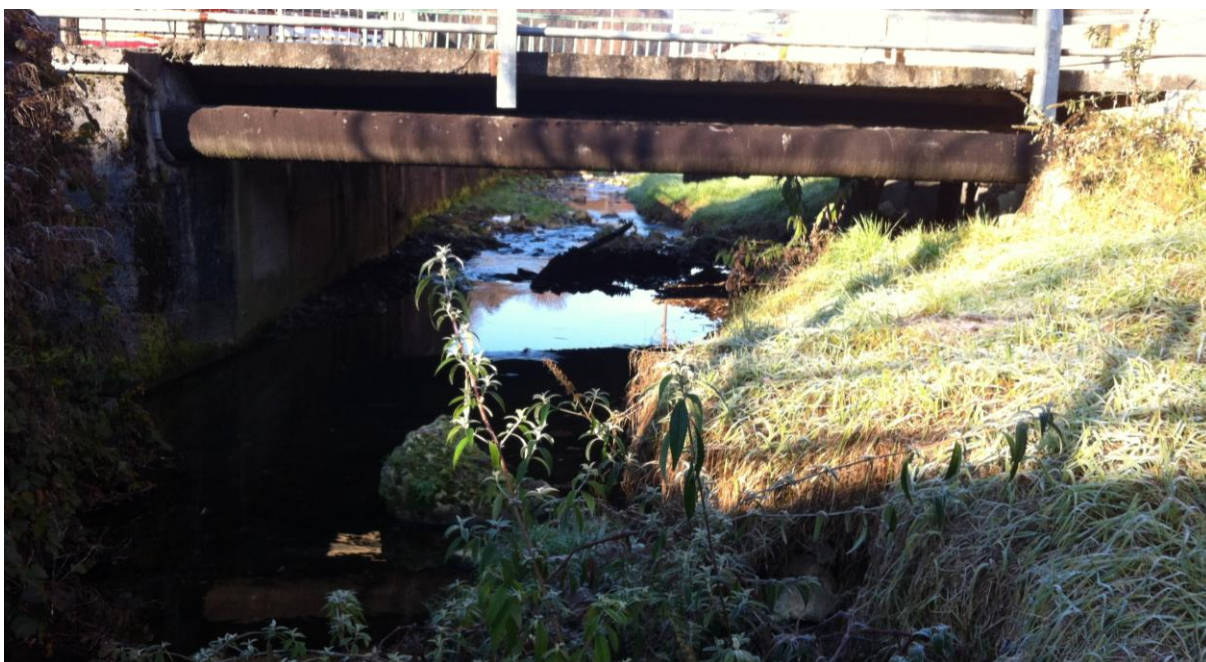
Fig. 34 - sezione di monte critica dell'attraversamento del torrente Rino, intersezione via Stadio e via Stelvio
