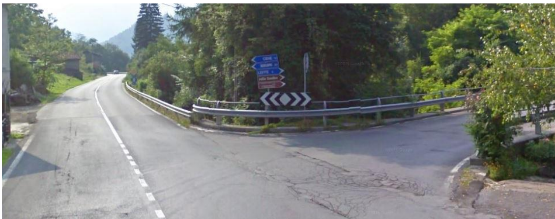
Fig. 21b - Strada di accesso al Comune di Leffe dalla Valle Rossa, streetview2011
