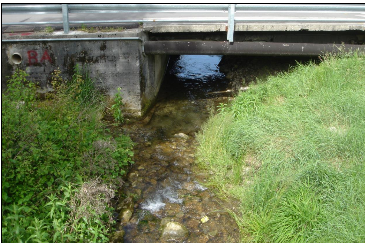
Fig. 44 - sezione critica dell'attraversamento del torrente Rino, intersezione via Stadio e via Stelvio, da monte verso valle (immagine 2007)
