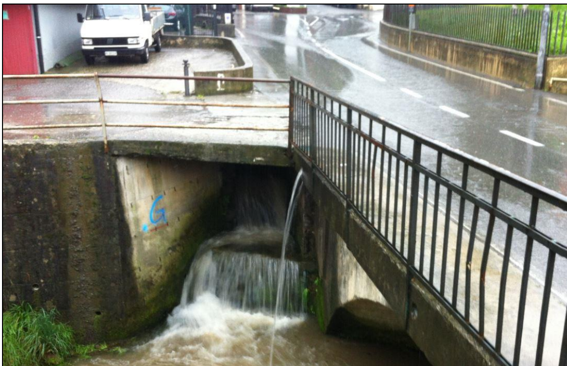
Fig. 58 – Sbocco Val Cazzano nel Torrente Rino
