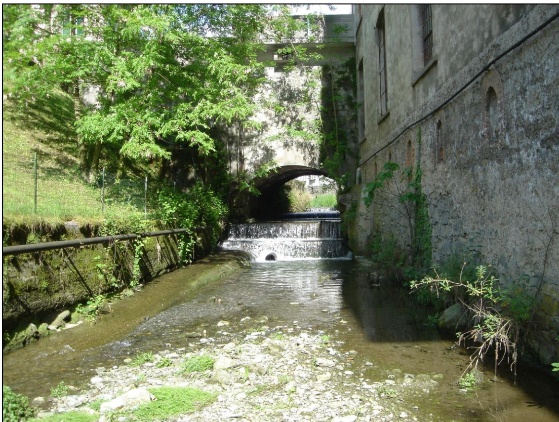
Fig. 37 – ponte di attraversamento in corrispondenza di via Dante di ampiezza ridotta
