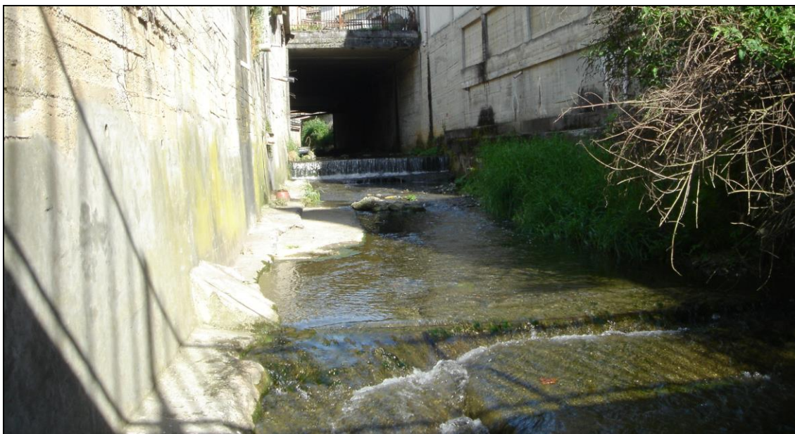
Fig. 39 – ponte di attraversamento a valle di via Piave, in corrispondenza di via Verdi
