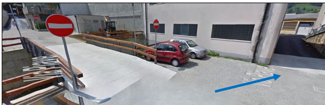
Fig. 36 – direzione di possibile esondazione, tombotto di monte di via Piave
