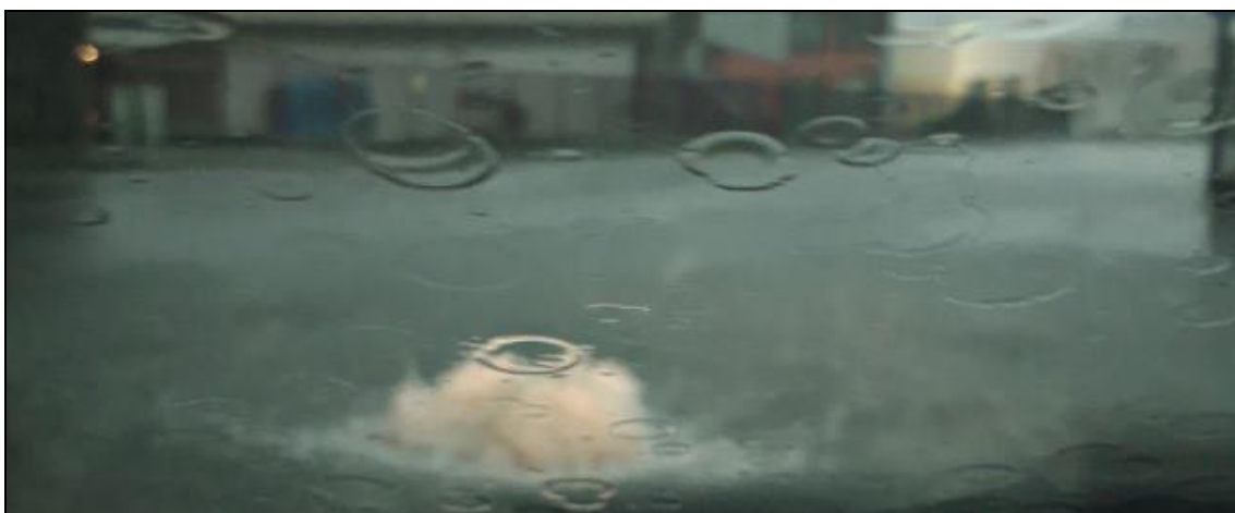
Fig. 22 – ruscellamenti lungo la strada che da via Manzoni di Gandino conduce verso Leffe e fuoriuscita degli apporti fognari dalle caditoie in corrispondenza di eventi meteorici intensi di agosto 2019
