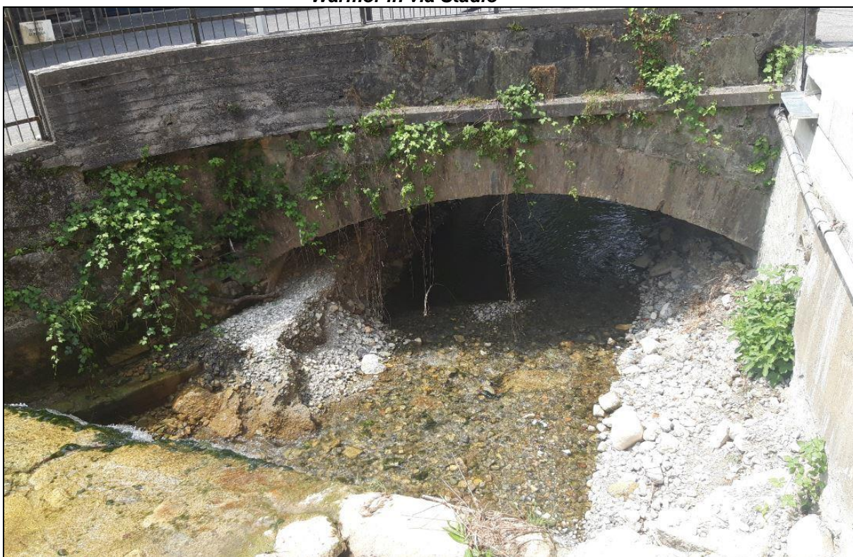
Fig. 41d – interventi di manutenzione del corso d'acqua con rideposizione dei detriti lungo i fianchi
