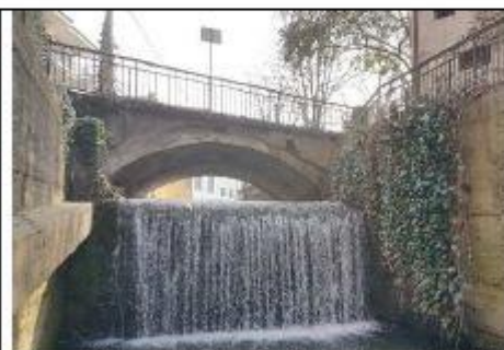
Figura 13. Vista da valle verso monte del salto presente a valle del ponte di via Stadio (sez. RI38)
