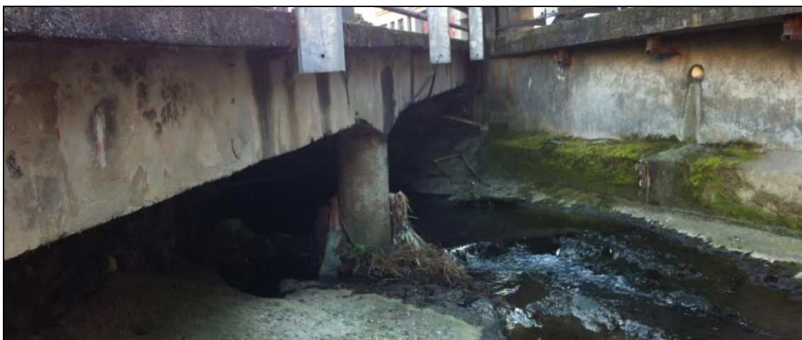
Fig. 34 – sbocco del tombotto in via Piave
