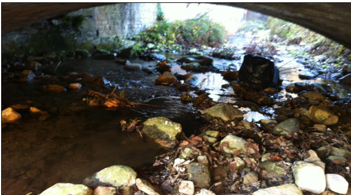
Fig. 41f - depositi alluvionali e materiale scarico sotto il ponte di attraversamento della ditta Warmor in via Stadio
