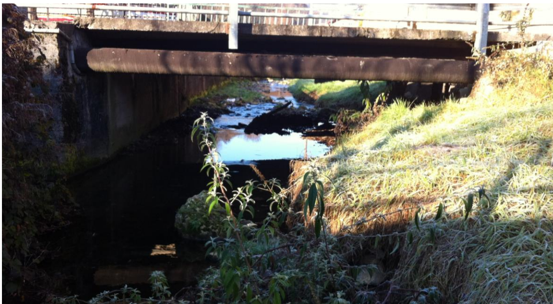
Fig. 45 - sezione critica dell'attraversamento del torrente Rino, intersezione via Stadio e via Stelvio, da monte verso valle (immagine 2016)
