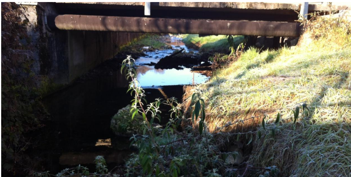
Fig. 43 - sezione di monte critica dell'attraversamento del torrente Rino, intersezione via Stadio e via Stelvio (2016)
