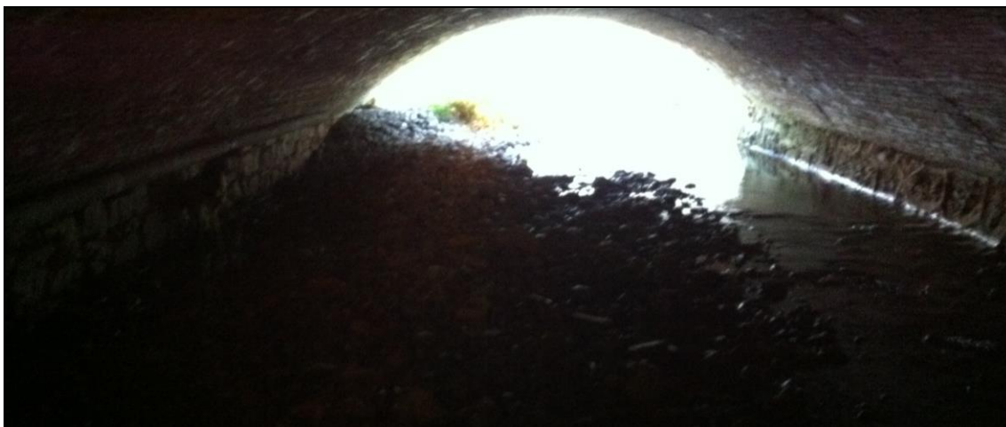
Fig. 30 - tratto di monte del tombotto di via Piave parzialmente ostruita da depositi alluvionali
