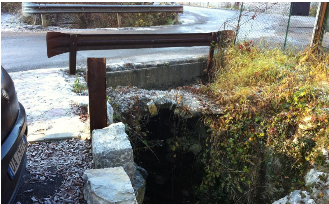
Fig. 47 - sezione di monte critica dell'attraversamento del torrente Rino, tratto di via Stadio a monte dello stadio "Martinelli"
