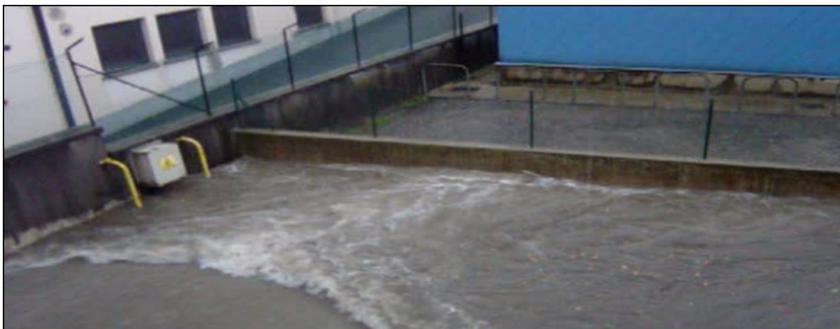
Fig. 20 – allagamenti aree produttive, immagine fornita dall'Ufficio Tecnico del Comune di Leffe
