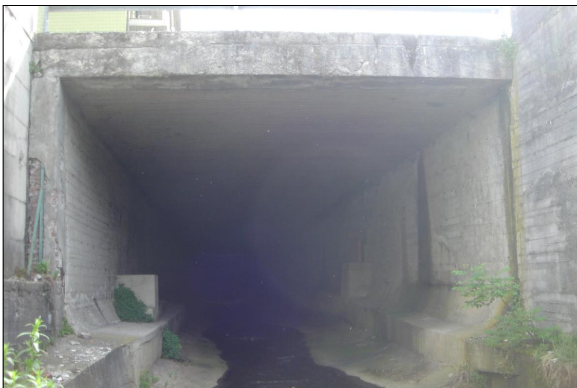
Fig. 54 – sezione di valle del tratto del torrente Rino tombottato in corrispondenza di via Brennero
