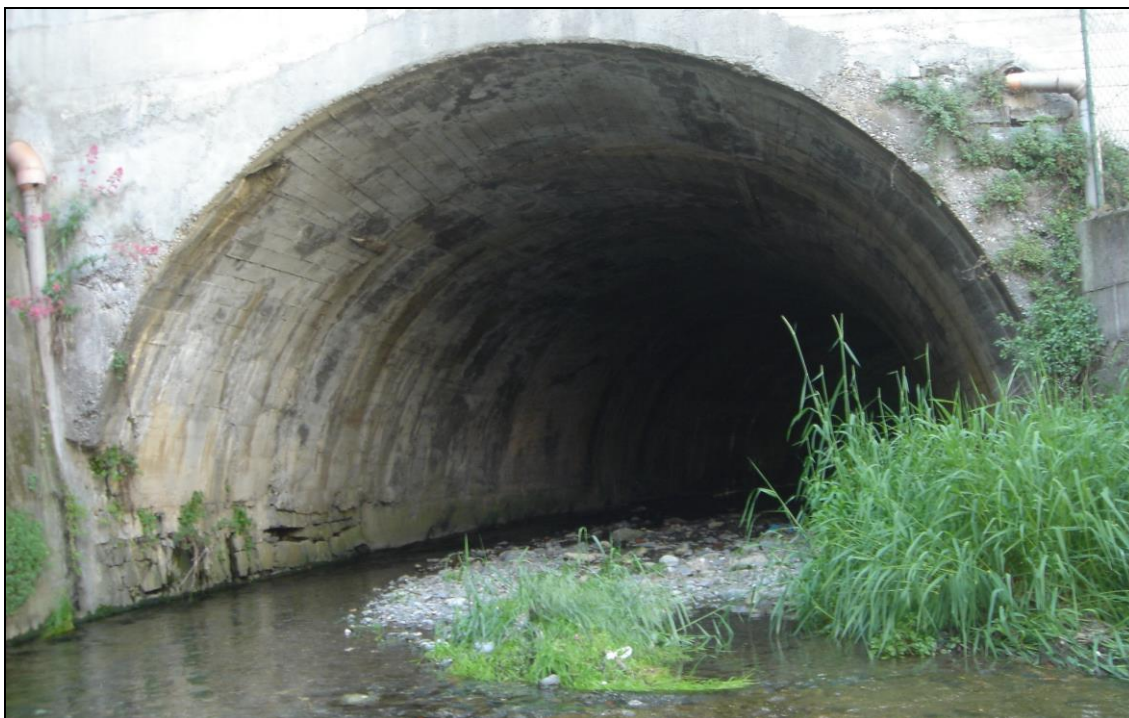
Fig. 38 – sbocco del tombotto in via dei Molini
