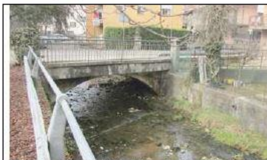
Figura 12. Vista del ponte di Via Stadio da monte verso valle (sez RI36)
